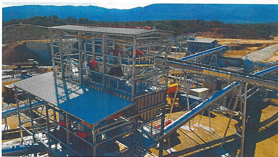
→ Bâtiment avec postes de broyage et criblage 3 avant bardage
