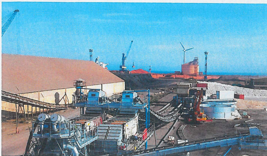
→ La nouvelle installation sur le Port de Fos-sur-Mer est configurée de façon à assurer le chargement d'un bateau de 30 000 tonnes en moins de 20 heures.
