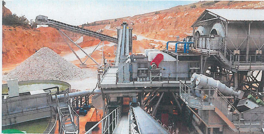
→ Les deux débourbeurs puis les deux cribles assurent le lavage et le calibrage du granulat avec un débit de 1 000 tonnes/heure.
