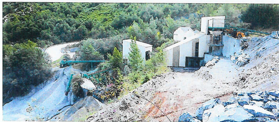
→ Vue d'ensemble du circuit secondaire avant modification.
