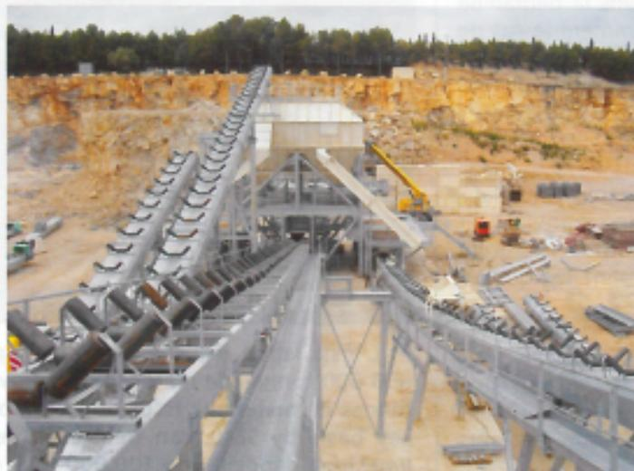
► Les différents convoyeurs à bande fixes de liaison en cours de montage / The different settled belt conveyors during assembly (doc. SMIL).
