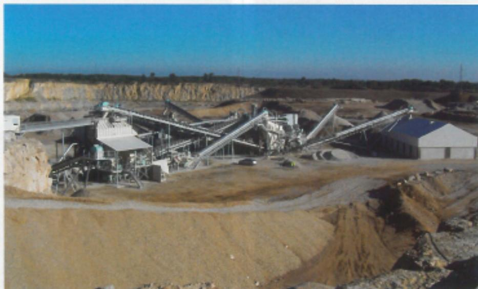
▶ L'installation réalisée clé en main par SMIL permet de traiter annuellement 650 000 tonnes de matériaux en provenance du gisement calcaire et 100 000 tonnes de matériaux issus de la démolition / The installation made on a turn-key basis by SMIL can treat each year 650,000 tons of materials from the limestone deposit, and 100,000 tons of materials from the demolition.
